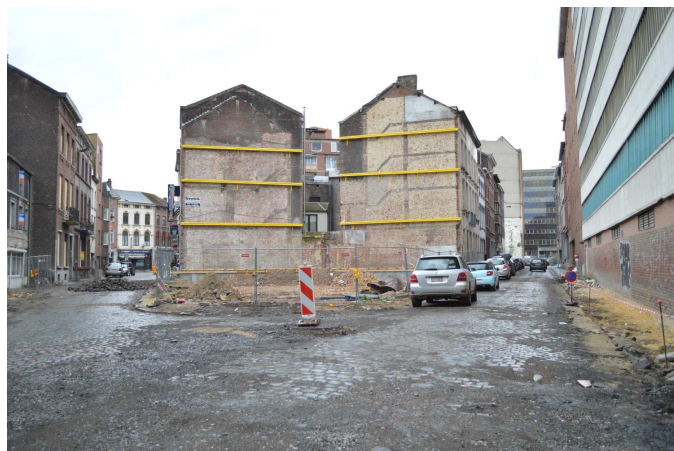
Travaux d'aménagement urbain dans le « Triangle » en 2013
